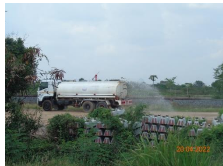
ภาพที่ 2.2-15 การฉีดพรมน้ำบริเวณที่พบฝุ่นละออง
