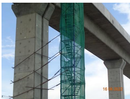
ภาพที่ 2.2-45 นั่งร้านและการตรวจสอบที่ใช้สำหรับงานก่อสร้าง
