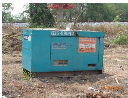
ภาพที่ 2.2-22 การปิดครอบเครื่องจักรจากแหล่งกำเนิดเสียง
