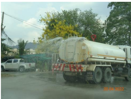
ภาพที่ 2.2-15 การฉีดพรมน้ำบริเวณที่พบฝุ่นละออง
